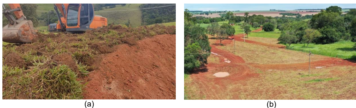
Figura 10 – Recuo e retorno da camada fértil do solo (a) e manejo da água de chuva na propriedade rural (b).
