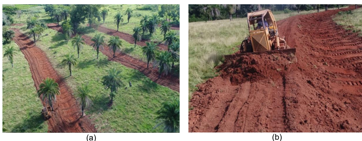
Figura 9 – Terraceamento em área de pastagem (a) e otimização da hora-máquina dos equipamentos de mobilização do solo (b).
